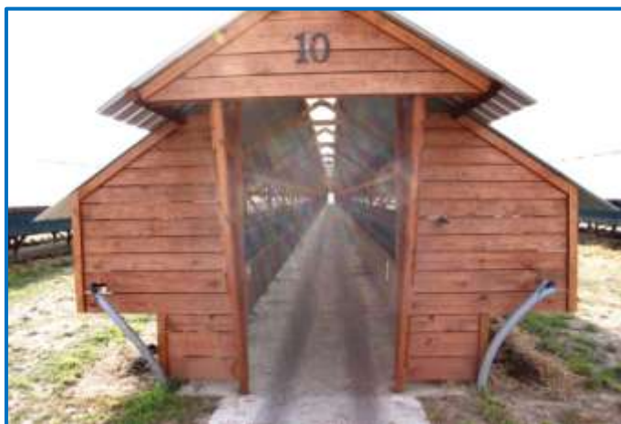
Fot. 2 Widok wejścia do pawilonu. Po dwóch stronach widoczny system doprowadzenia wody
