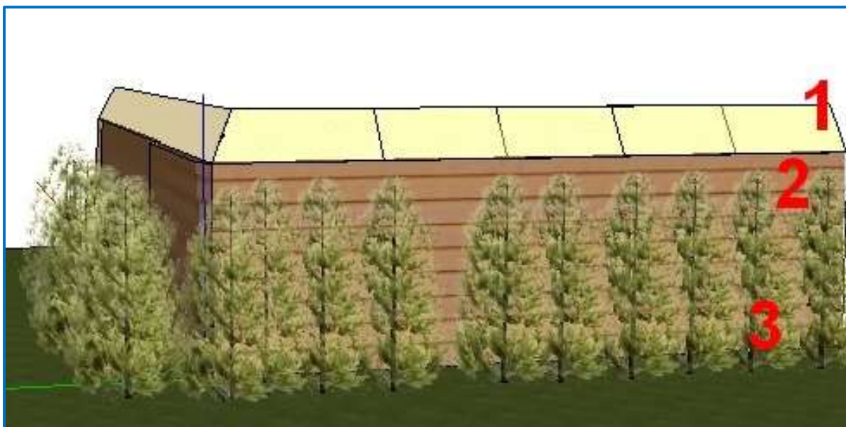
Rys. 5 Przedstawia ogrodzenie widziane z zewnątrz fermy. 1- nachylony pastuch elektryczny, 2 - prefabrykowane ogrodzenie betonowe, 3 – pas zieleni izolującej
