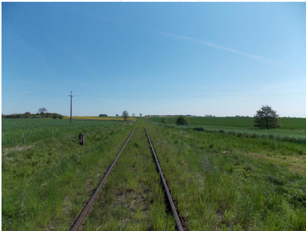
Fot. 1. Linia kolejowa pod Prusinowem – fragment transektu; po prawej stronie tereny inwestycyjne (fot. S. Popek)
