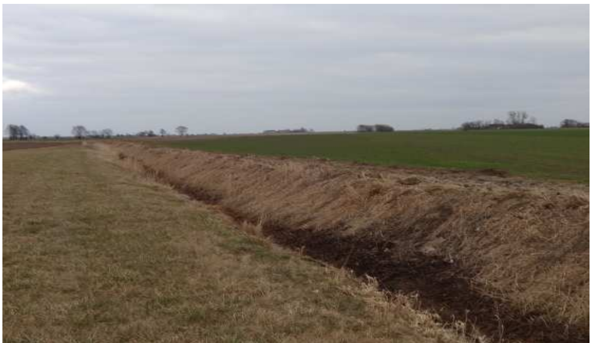
Fot. 2. Rów melioracyjny 2
