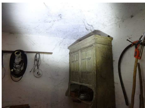
Fot .3. Widok przykładowego kontrolowanego pomieszczenia we wsi Kamionka.
