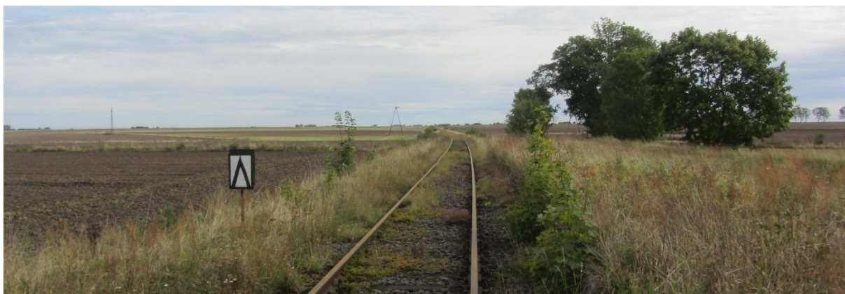
FOT. 4 WIDOK Z PRZEJAZDU KOLEJOWEGO W JĘDRZEJEWIE W KIERUNKU WSCHODNIM. WIDOK W KIERUNKU TURBINY NR 3
