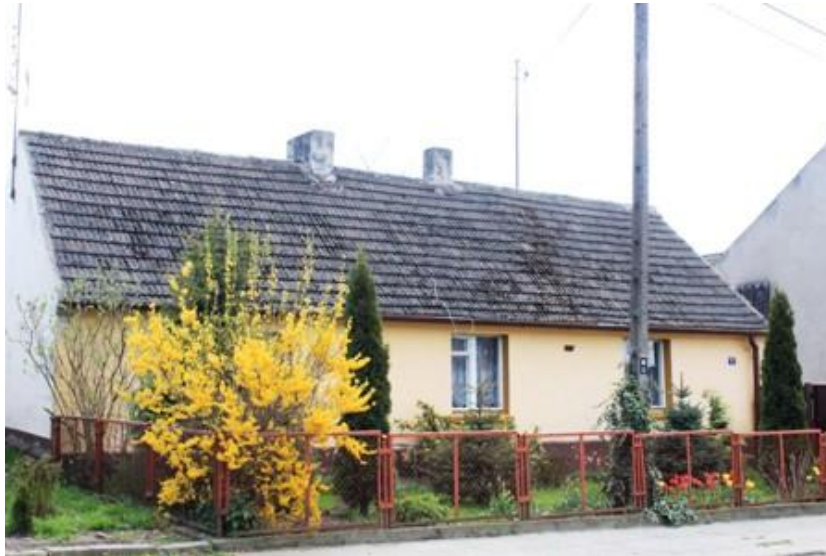
Dębe – dom, ul. Starowiejska 13
