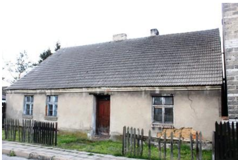
Lubasz – dom, ul. Wiejska 17
