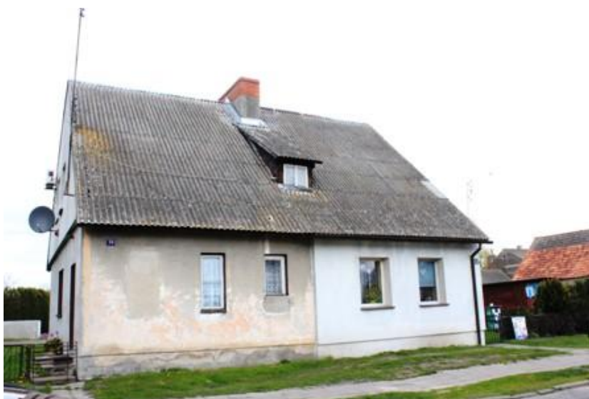
Lubasz – dom, ul. Wiejska 35
