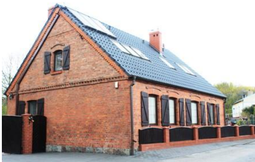
Lubasz – dom, ul. Wiejska 25
