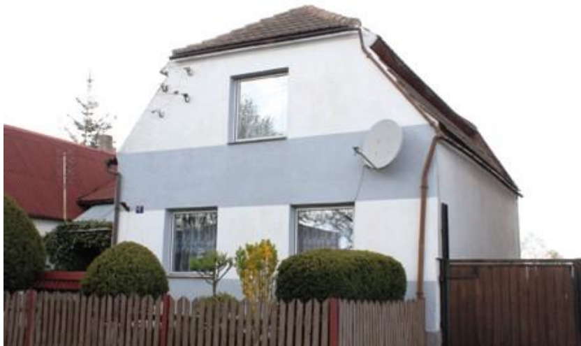
Lubasz – dom, ul. Wiejska 5
