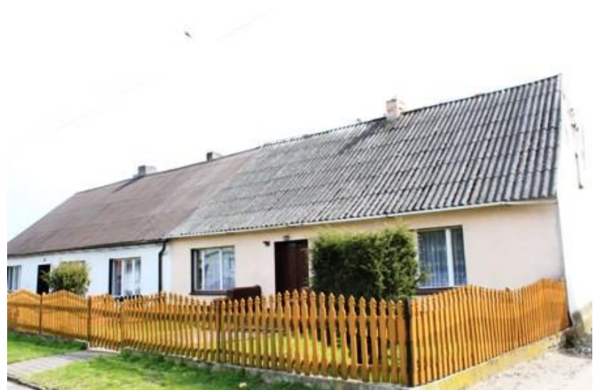
Lubasz – dom, ul. Wiejska 12/14
