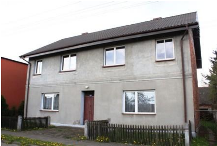
Lubasz – dom, ul. Wiejska 13
