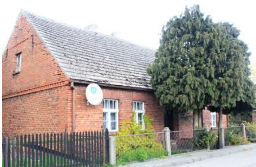
Lubasz – dom, ul. Wiejska 21
