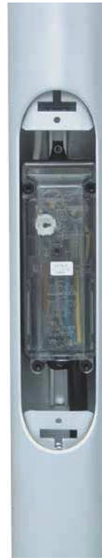
Złącze słupowe we wnęce słupa aluminiowego
