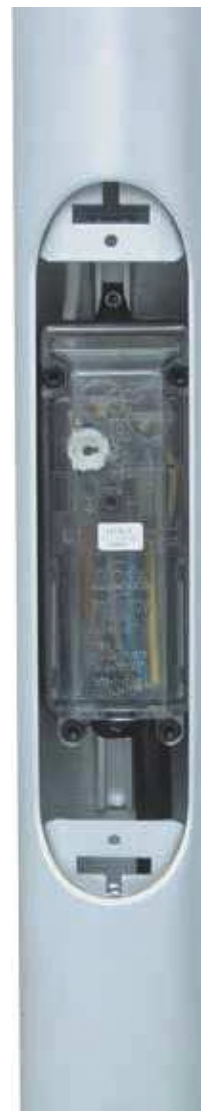
Złącze słupowe we wnęce słupa aluminiowego
