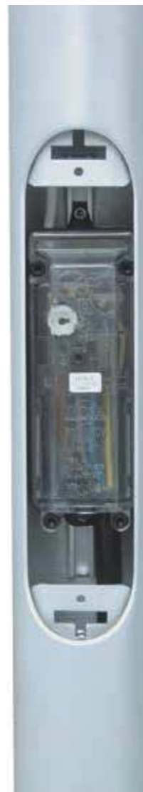
Złącze słupowe we wnęce słupa aluminiowego
