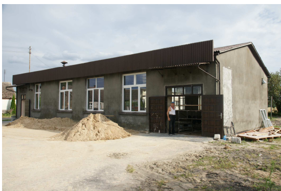
Rysunek 3. Budynek remontowanej świetlicy wiejskiej.
