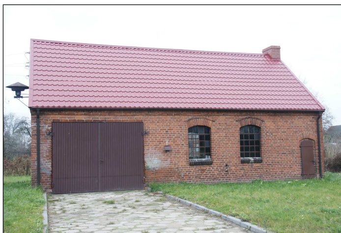
Rysunek 1. Budynek po starej kuźni.
