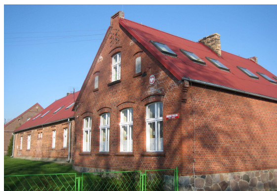
Fot.4. Budynek Szkoły Podstawowej
